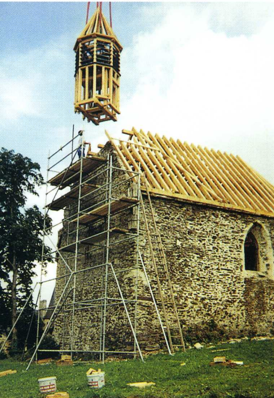
Agneaux (Manche) Chapelle Sainte-Marie 1. Mise en place du clocher 2. Charpente de la chapelle durant les travaux
