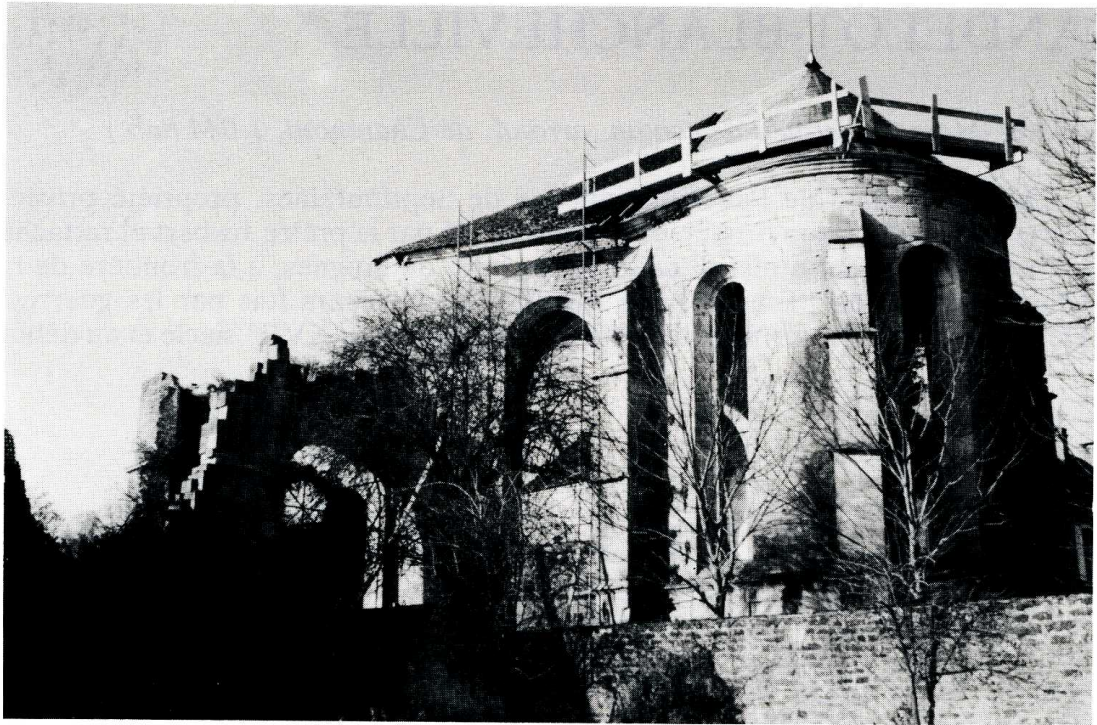
Andelot-Blancheville (Haute-Marne). Chapelle de l'ancienne abbaye de Septfontaines.
