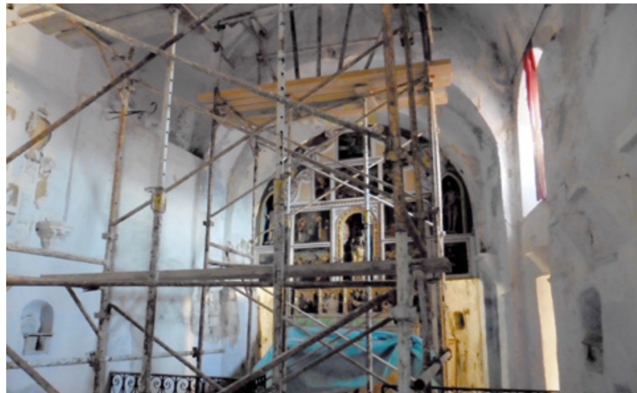
6. Vue intérieure vers le chœur pendant les travaux
