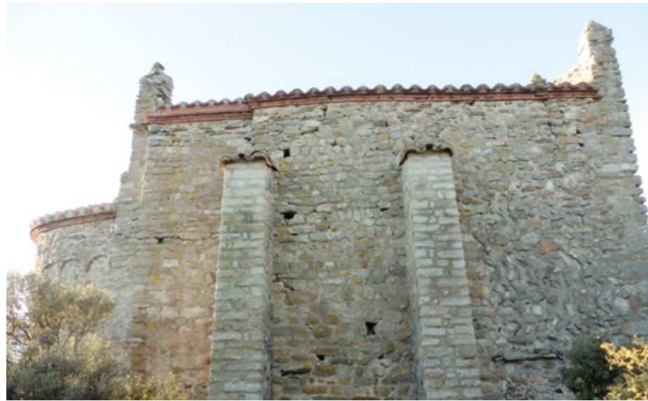
5. Vue de la façade nord
