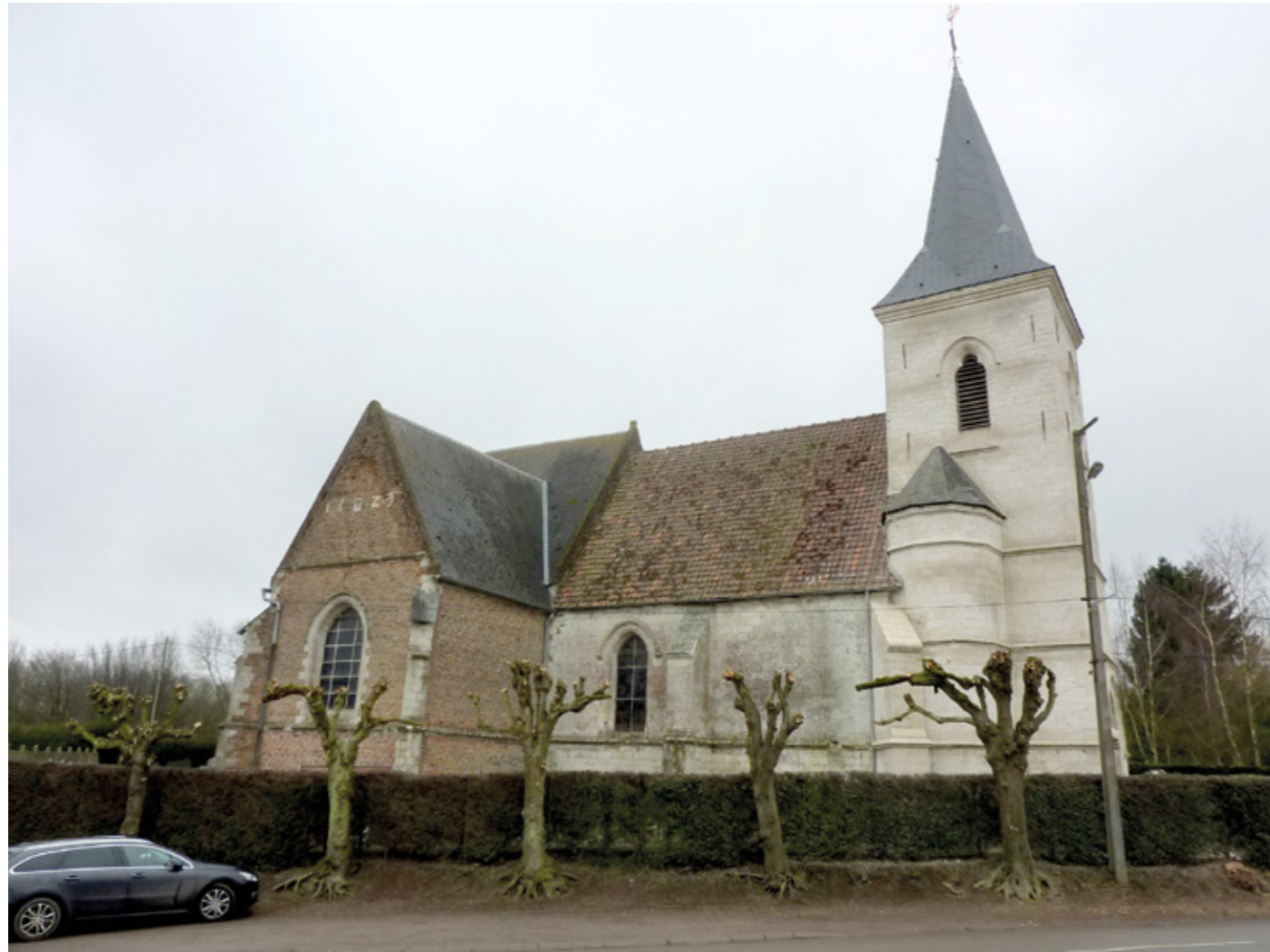
1. Vue de la façade nord
