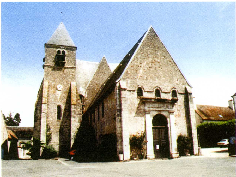
Beaulieu-sur-Loire (Loiret) Église Saint-Étienne Clocher et façade occidentale
