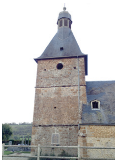
4. Vue sud du clocher-porche
