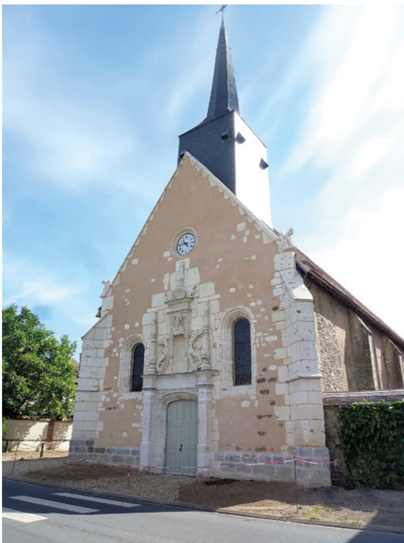
1. Façade ouest après restauration
