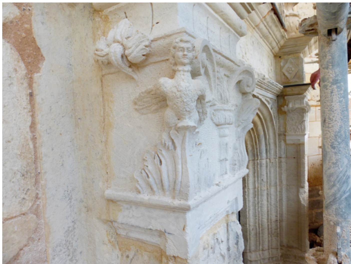
4. Autre détail du portail en cours de restauration
