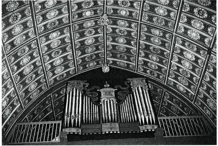
Bouelles (Seine-Maritime). Église Saint-Martin. Lambris du côté ouest après restauration (atelier Legrand, 1998).
