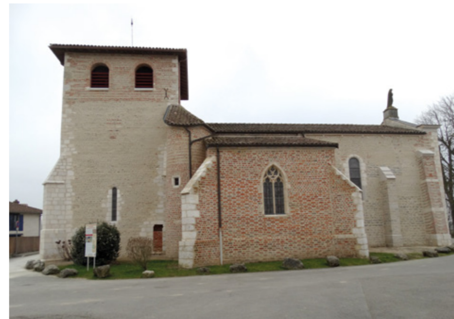
4. Façade nord après restauration
