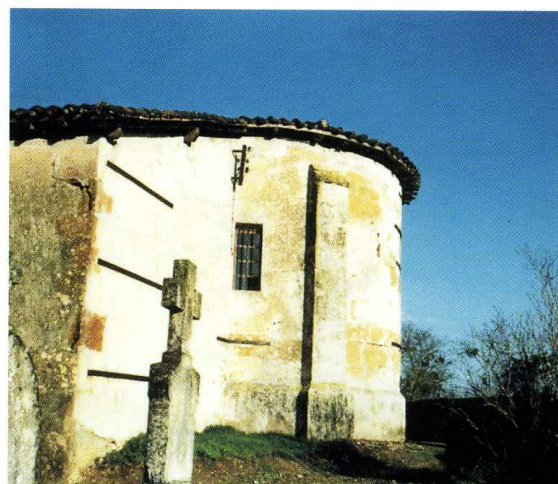
2 Carcarès-Sainte-Croix (Landes) Église Saint-Pierre-ès-Liens de Sainte-Croix 2. Chevet 3. Abside en cours de travaux
