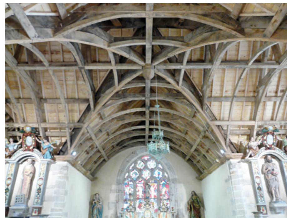
6. Vue de la charpente après dépose du lambris
