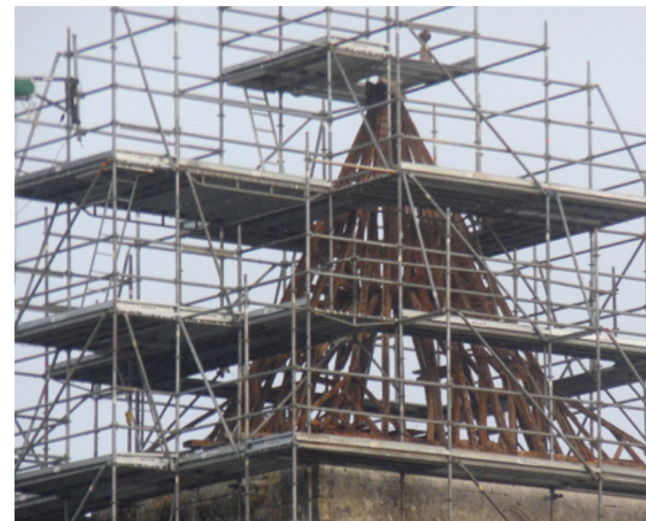
10. Flèche du clocher en cours de restauration
