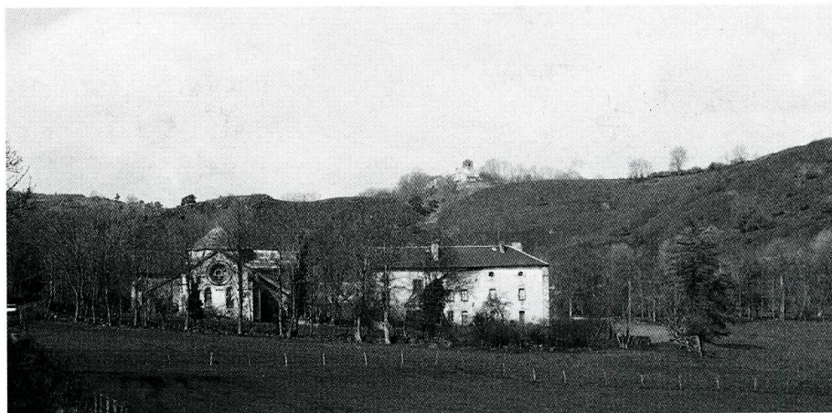
Chassagne (Puy-de-Dôme), l'église abbatiale et le logis dominés par l'église paroissiale.
