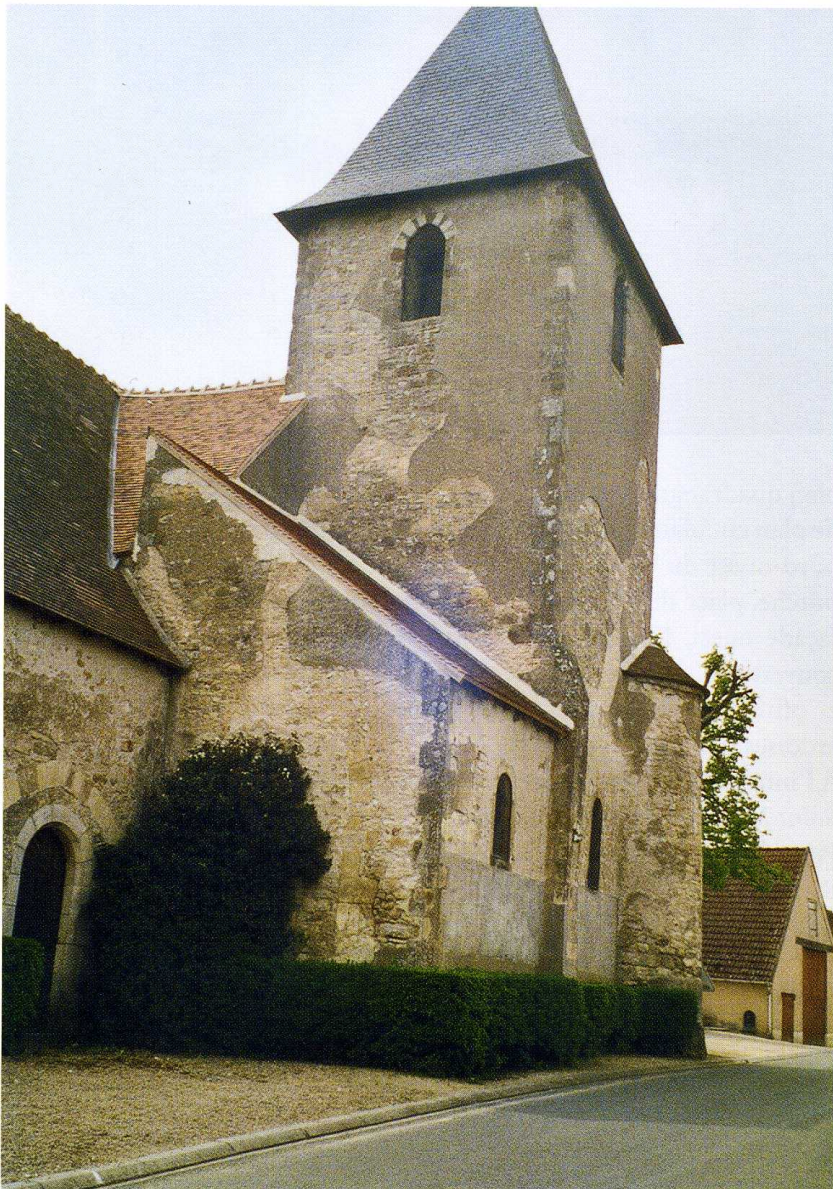
Château-sur-Allier (Allier) Église Saint-Maurice Le clocher vu du nord est
