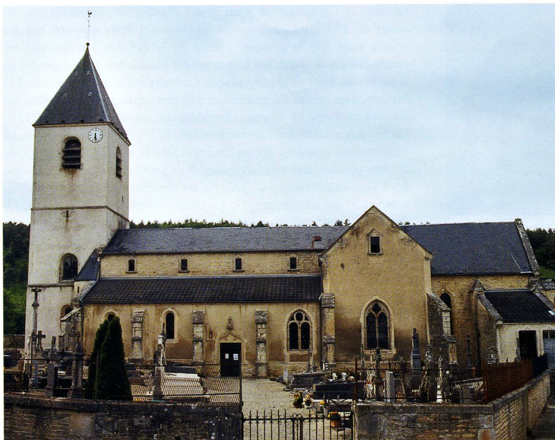
Châteauvillain (Haute-Marne) Église Notre-Dame-de-la-Nativité de Créancey Vue d'ensemble côté sud
