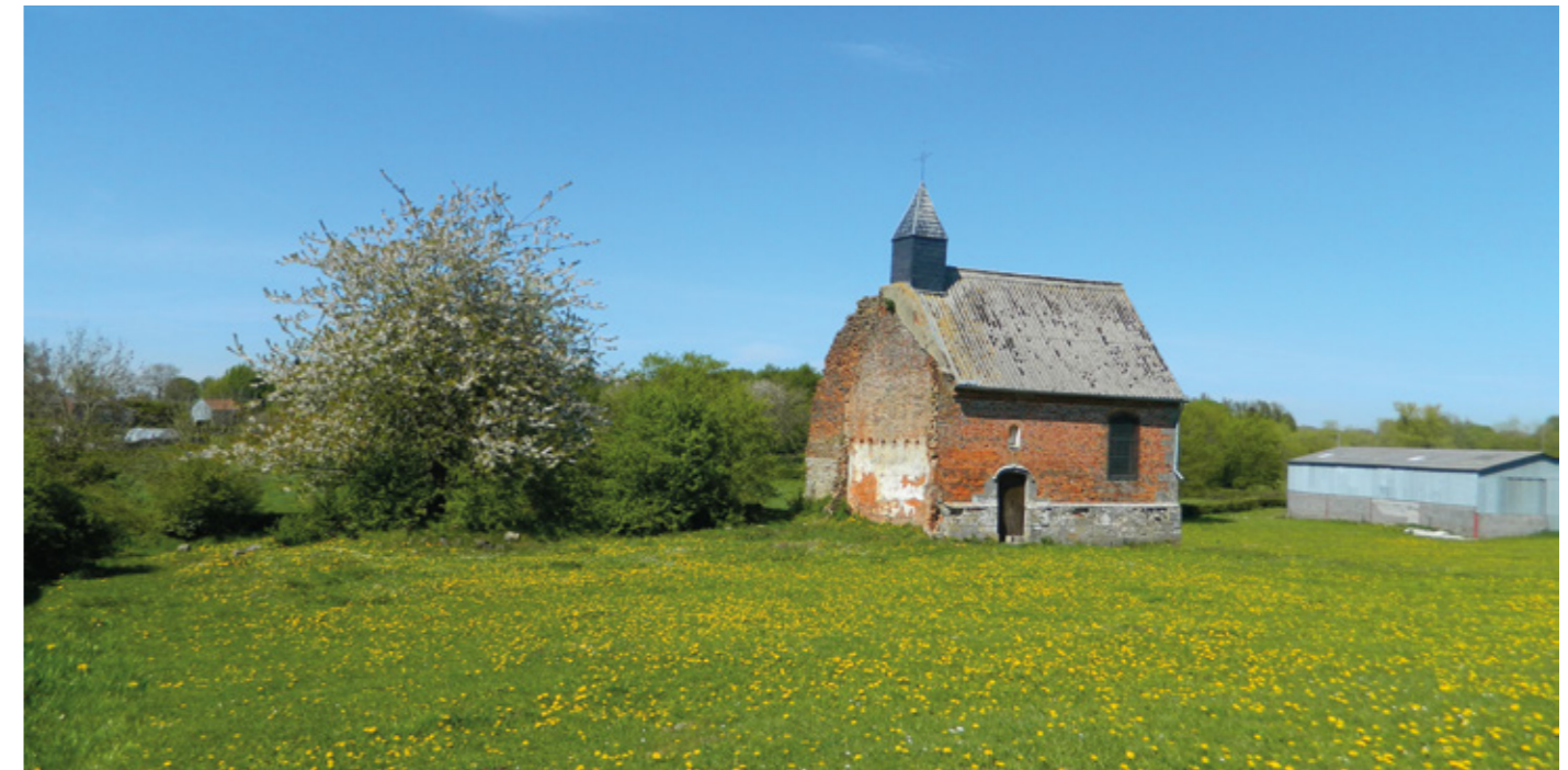
1. Vue sud-est de la chapelle avant restauration
