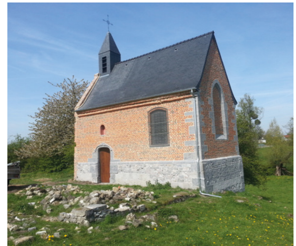
2. Vue sud-ouest de la chapelle restaurée
