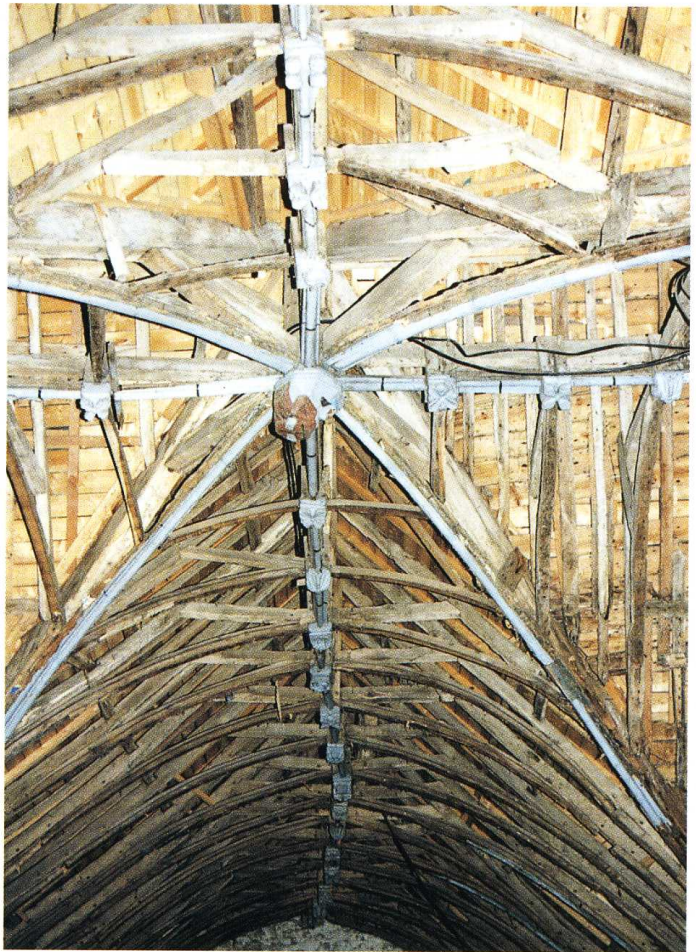
Le Croisty (Morbihan) Église Saint-Jean-Baptiste 3. Charpente de la nef et du chœur, après dépose de la voûte 4. About de blochet figuré
