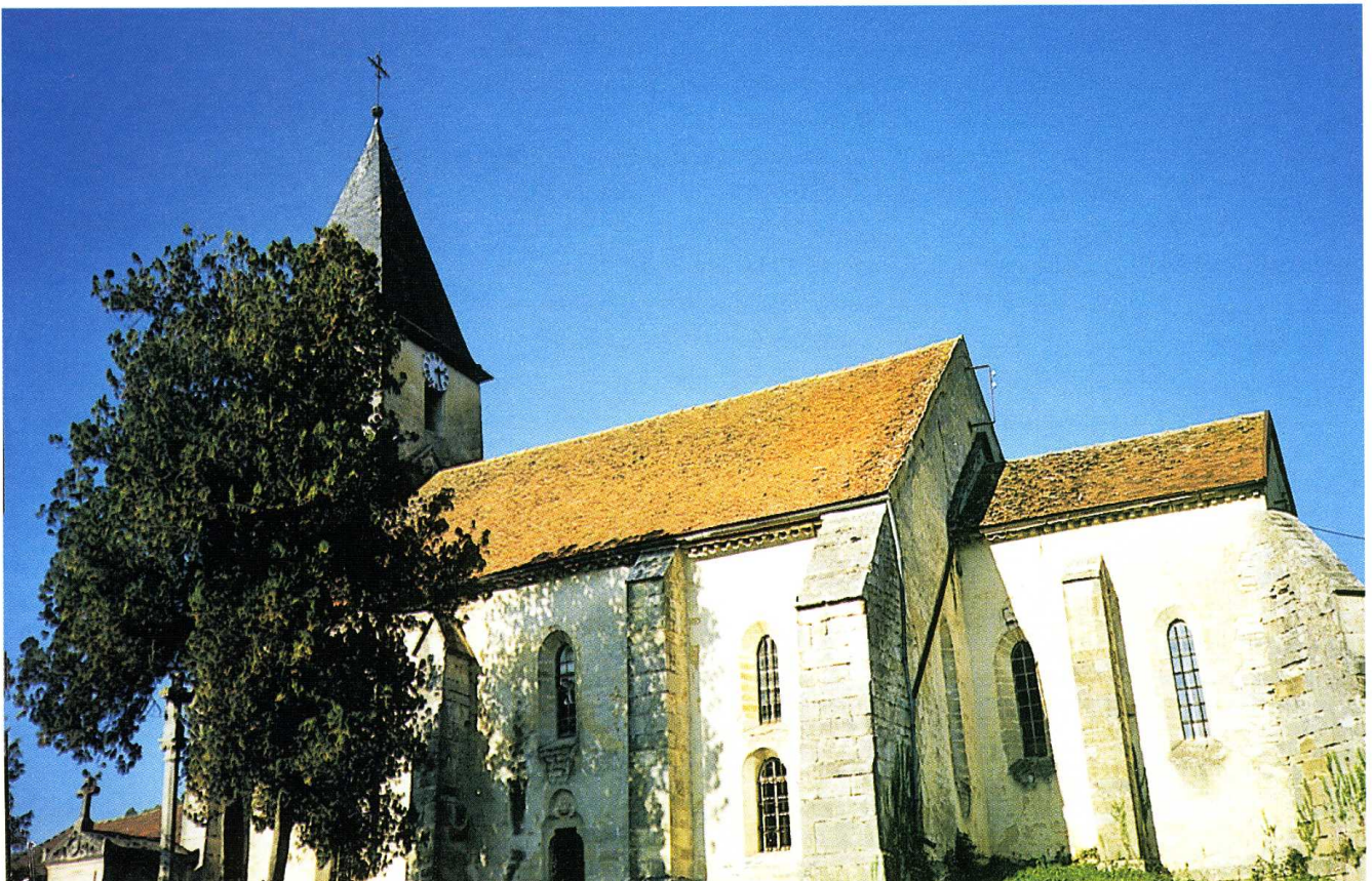
Darcey (Côte-d'Or) Église Saint-Bénigne Vue du côté sud
