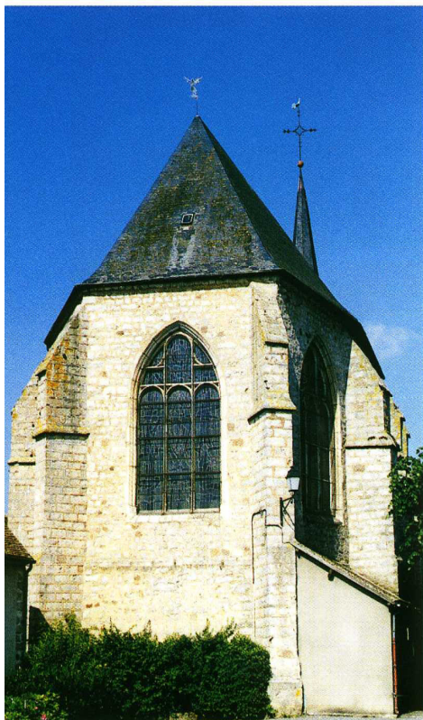
Domats (Yonne) Église Saint-Remi 1. Chevet 2. Vue intérieure vers l'abside
