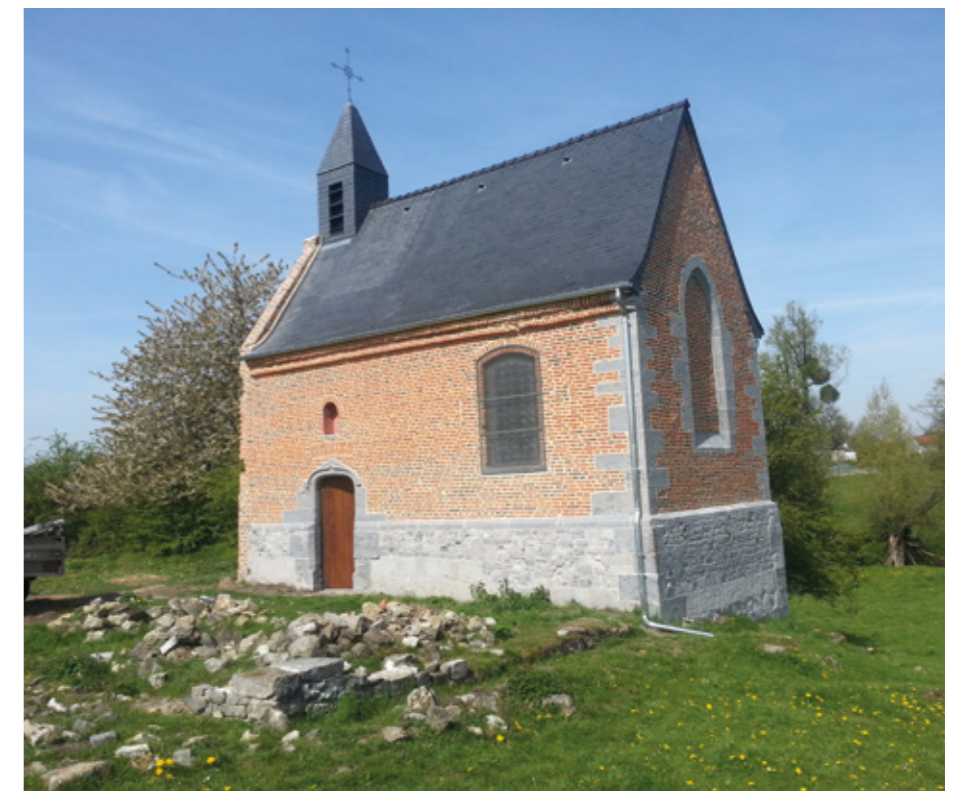
2. Vue sud-ouest de la chapelle restaurée
