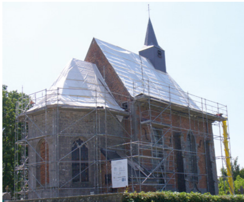
4. Vue sud-est de l'édifice en cours de restauration
