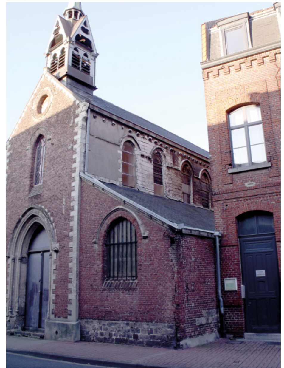
1. Façade occidentale, côté rue
