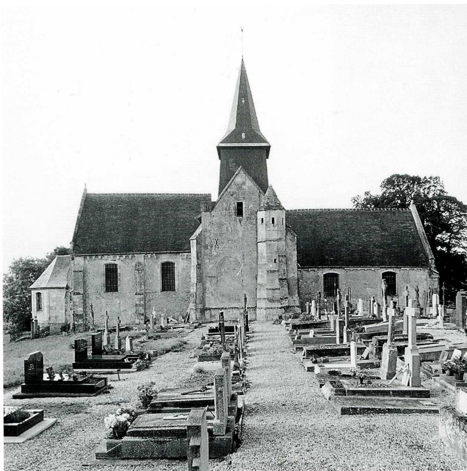
Douville-en-Auge (Calvados), église Notre-Dame. Façade nord.
