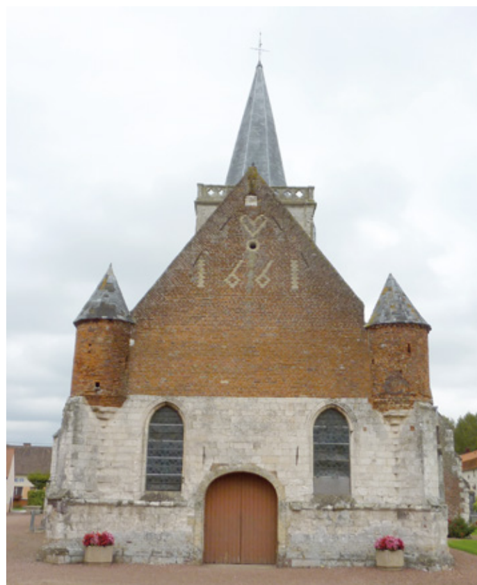
2. Vue de la façade occidentale
