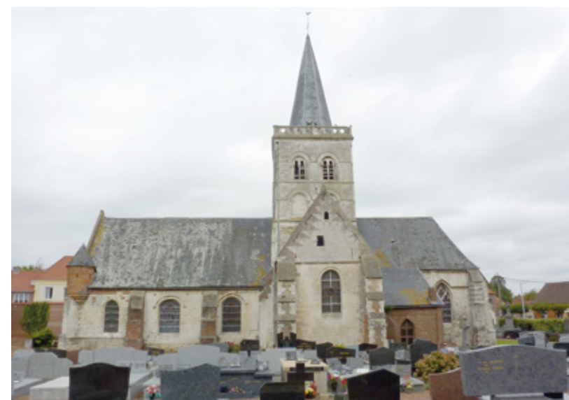
4. Façade sud avant restauration
