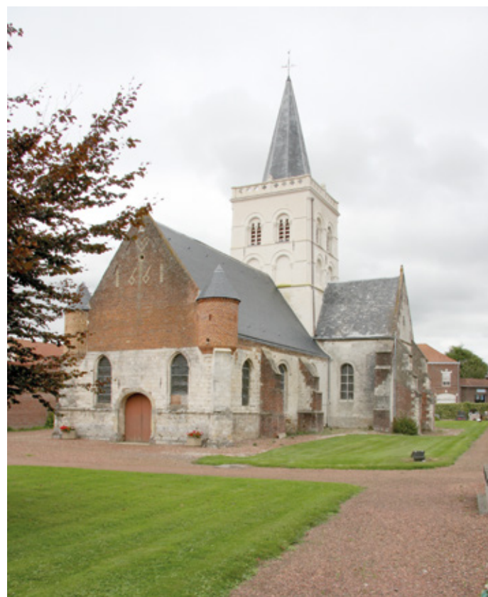
3. Façade du sud-ouest après restauration
