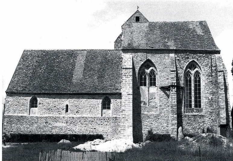
Les Écrennes (Seine-et-Marne). Église Saint-Laurent, façade sud.
