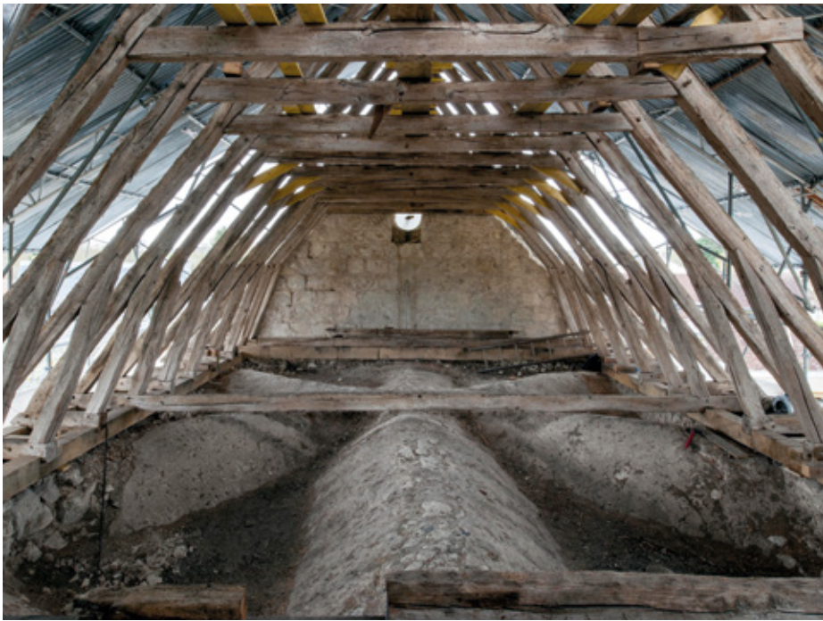
7. Vue de la charpente à chevrons-formant-ferme de la nef (cl. T. Cantalupo, ©Inventaire général région Centre-Val de Loire)
