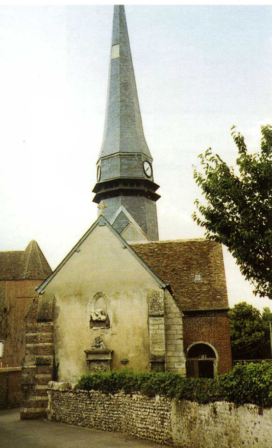
Éragny-sur-Epte (Oise) Église Saint-Martin 1. Façade occidentale 2. Chevet de l'église
