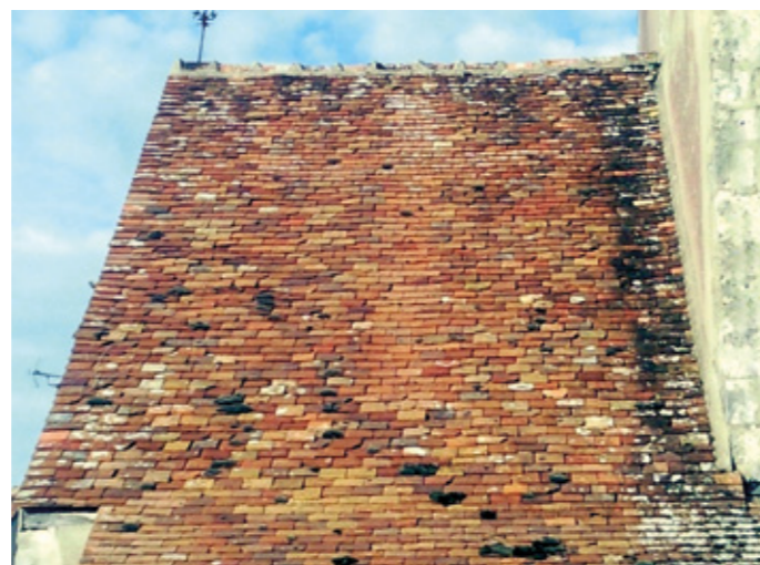
9. Vue de la couverture en tuile
