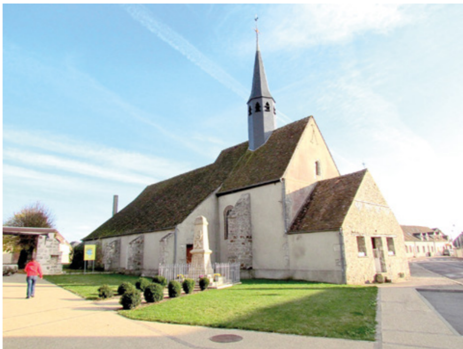
1. Façade nord avant travaux
