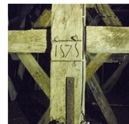
12. Détail de la charpente du clocher
