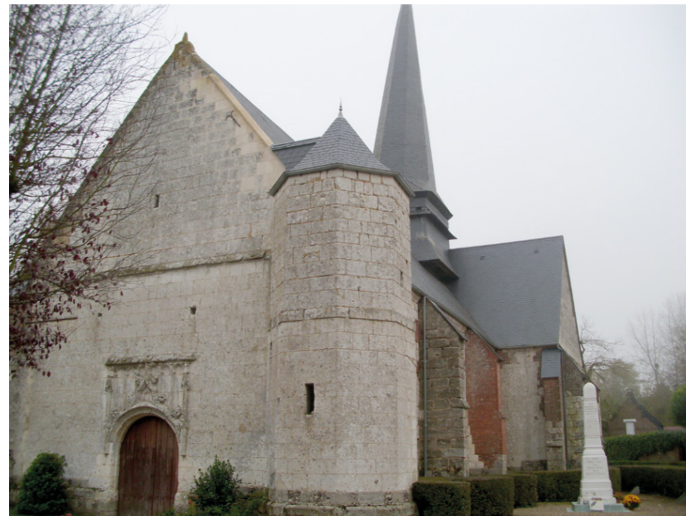
1. Vue sud-ouest de l'église
