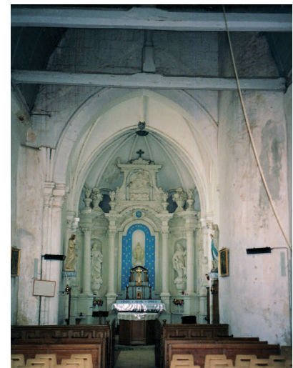
5. Vue intérieure vers l'abside
