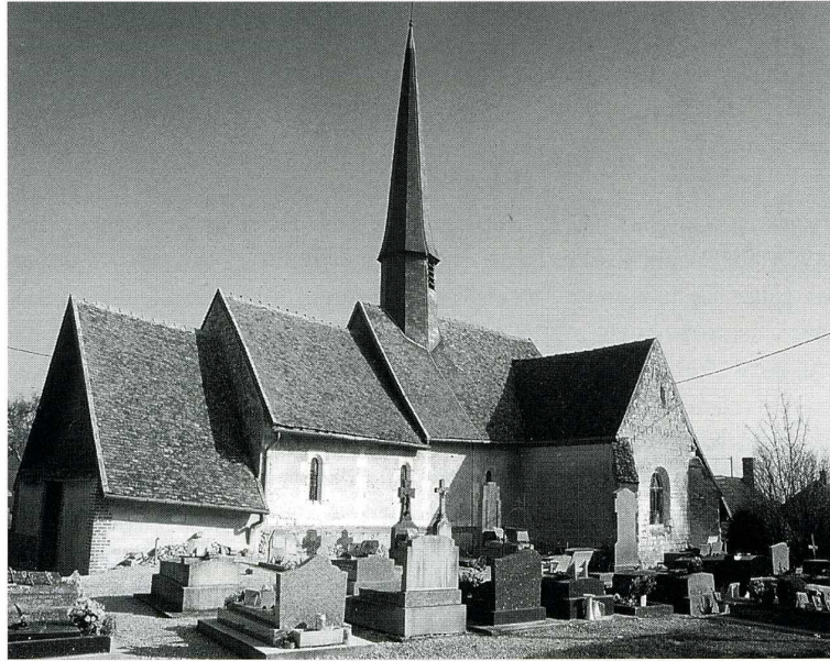
Feuges (Aube), église Saint-Benoît. Vue générale de l'édifice du côté sud.
