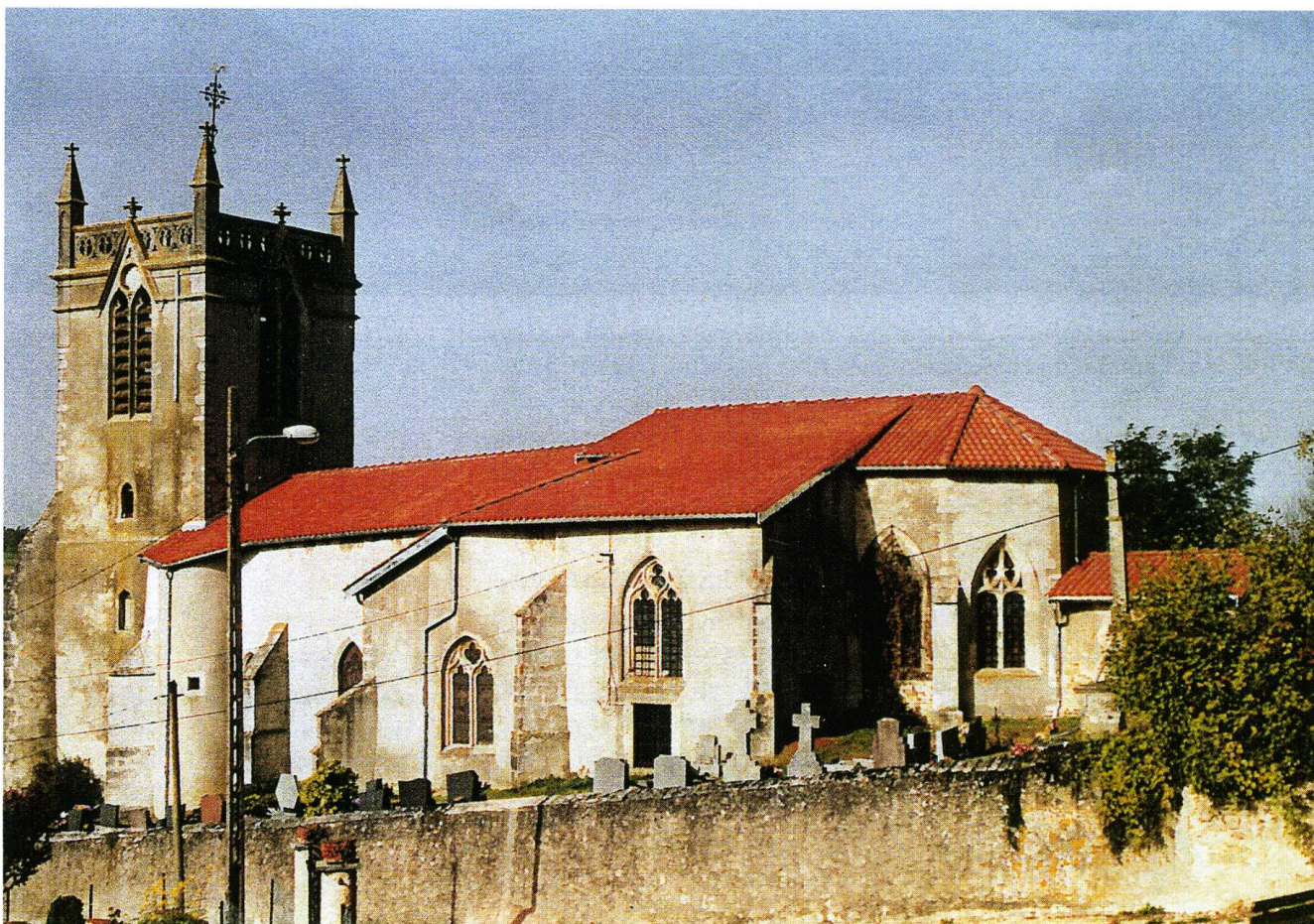
1 Germiny (Meurthe-et-Moselle) Église Saint-Epvre 1. Façades sud et est après travaux
