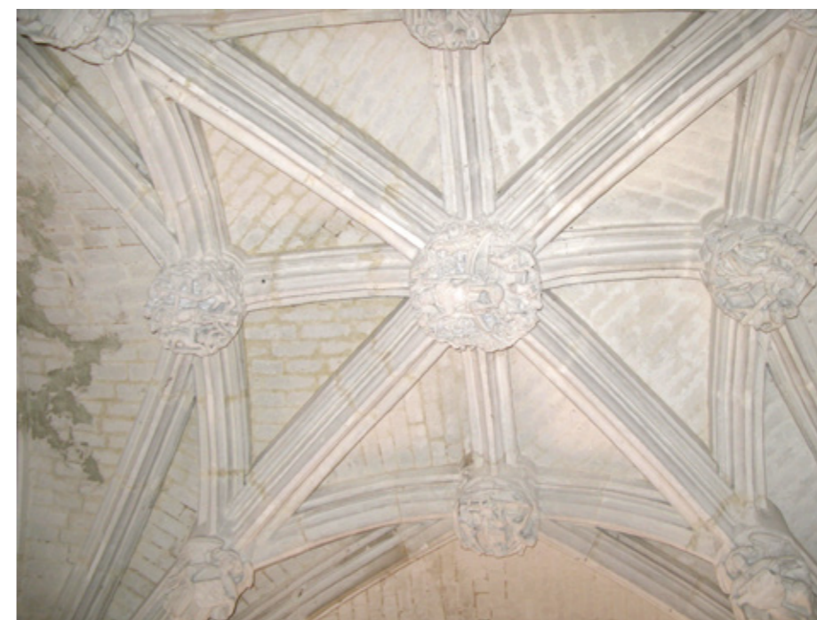
7. Voûte de l'ancienne chapelle seigneuriale
