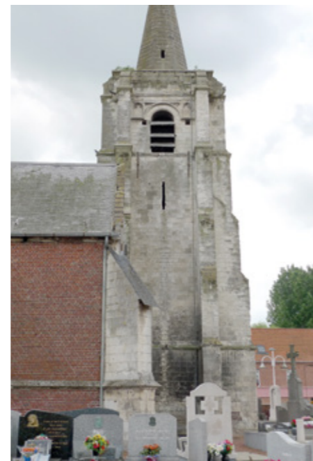
3. Vue de la façade nord
