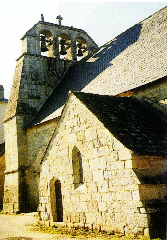
Gourdon-Murat (Corrèze) Église Saint-Pierre-aux-Liens 1. Façade et chapelle sud 2. Façade nord
