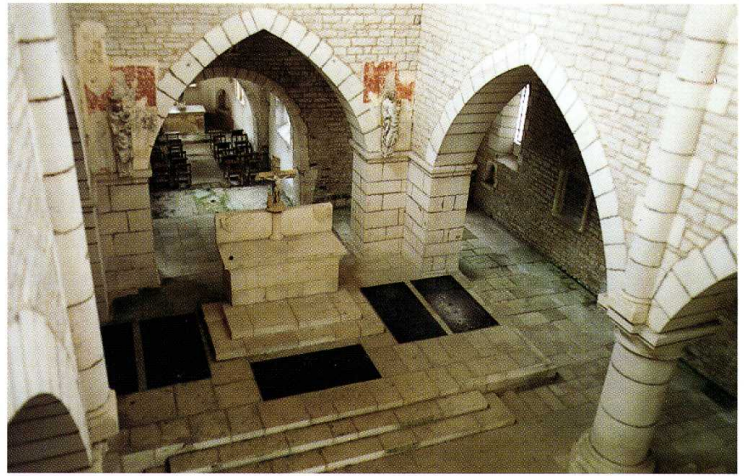
Grancey-le-Château-Neuve (Côte-d'Or) Collégiale Saint-Jean-l'Évangéliste 1. Croisée de la collégiale et vue sur l'intérieur de la chapelle ancienne 2. Chevet de l'ancienne chapelle (clichés P. de Maulmin, 1997)
