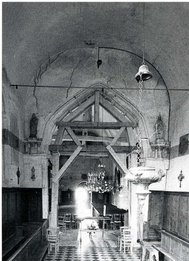
2. Grangues. Chœur avant restauration.
