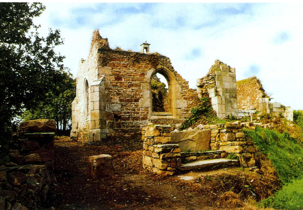
Guimaëc (Finistère) Chapelle de Christ Façade est avant travaux
