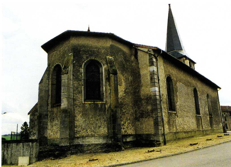
Harmonville (Vosges) Église Saint-Brice Vue générale
