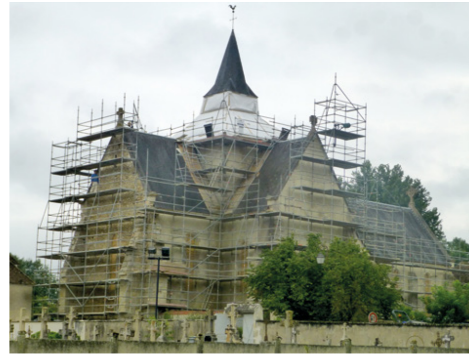
5. Église en cours de restauration
