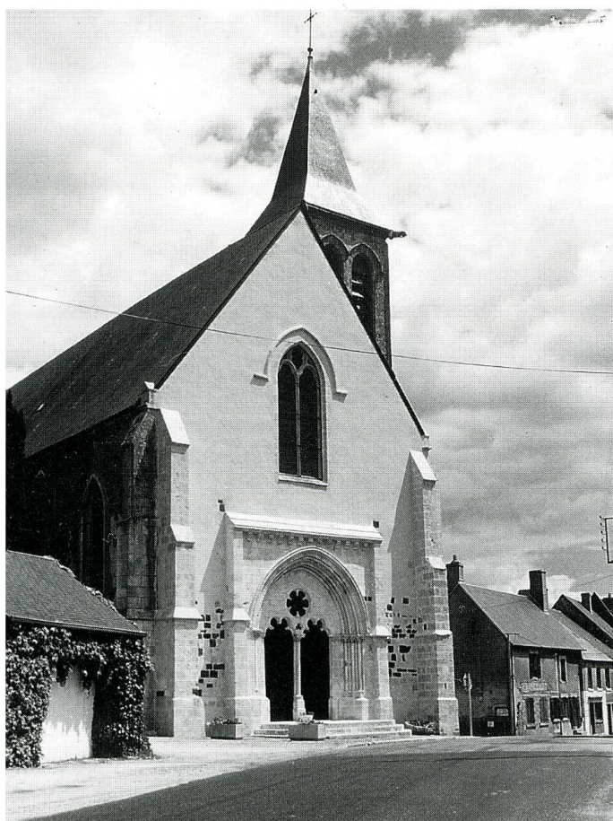
Ivoy-le-Pré (Cher), église Saint-Aignan. Façade occidentale après restauration.
