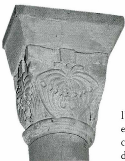
Jaillans (Drôme), église Sainte-Marie, chapiteaux coiffant les demi-colonnes engagées supportant les arcs-doubleaux.
