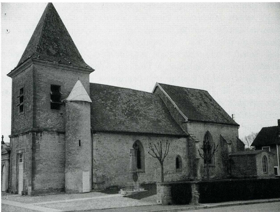
Jessains (Aube). Église Saint-Pierre-ès-Liens, vue d'ensemble côté sud.
