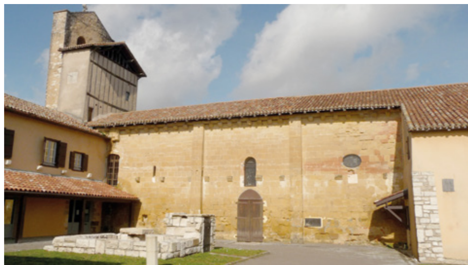
3. Vue de la façade sud
