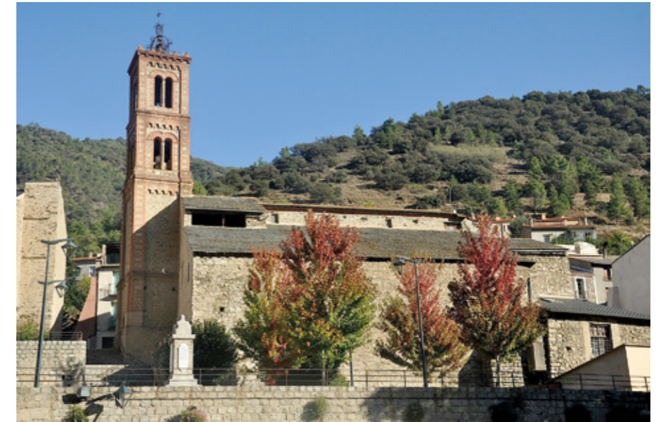
1. Façade sud et clocher
