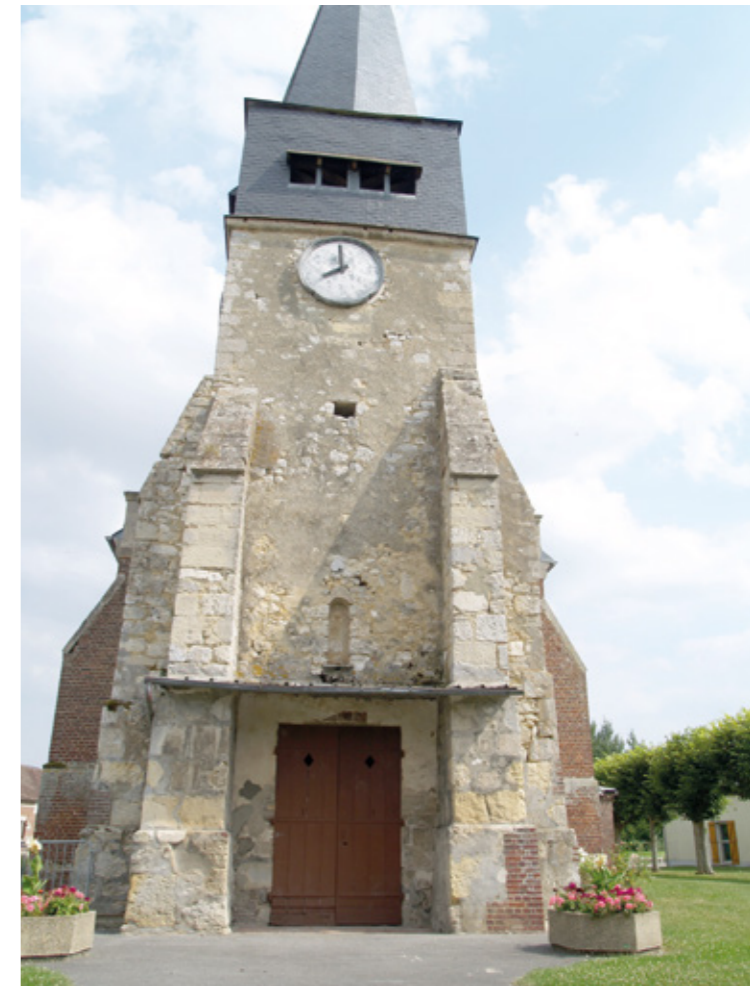
1. Clocher-porche en façade occidentale
