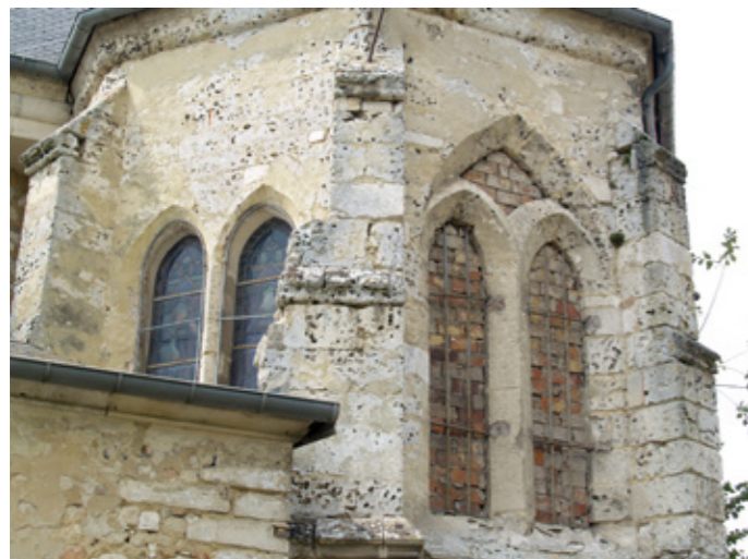
4. Vue sud-est du chevet avant restauration
