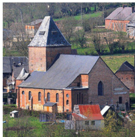
1. Vue sud-est de l'édifice
