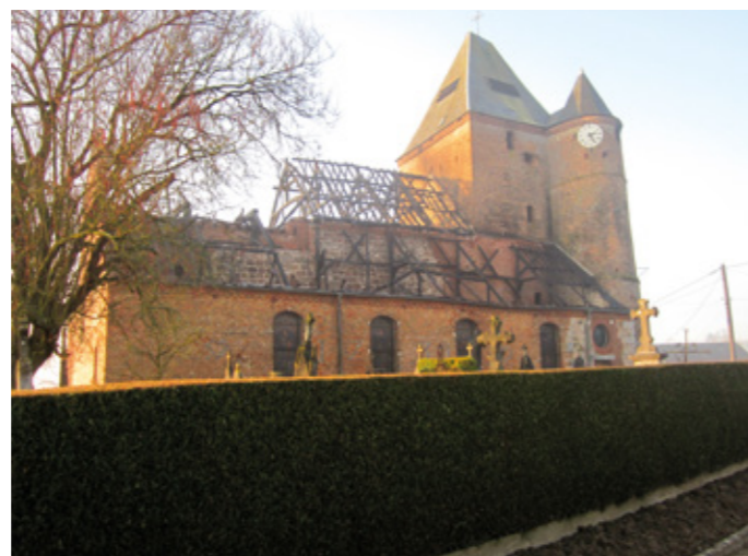
4. État de l'édifice après l'incendie
