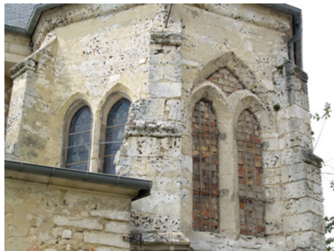
4. Vue sud-est du chevet avant restauration
