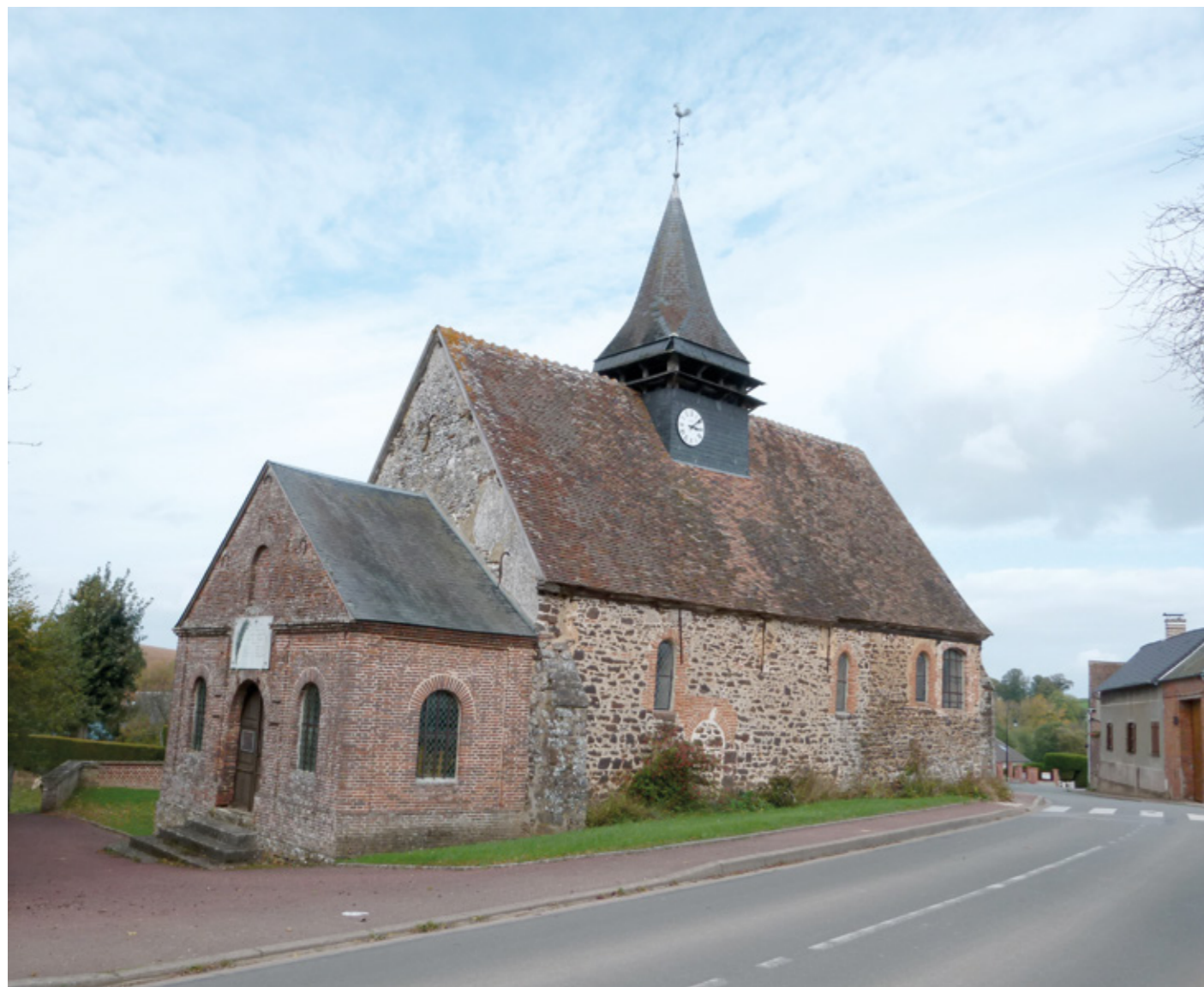
3. Vue sud-ouest de l'église
