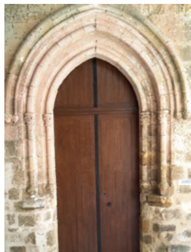
4. Portail ouest 5. Façade nord 6. L'église vue du sud-est
