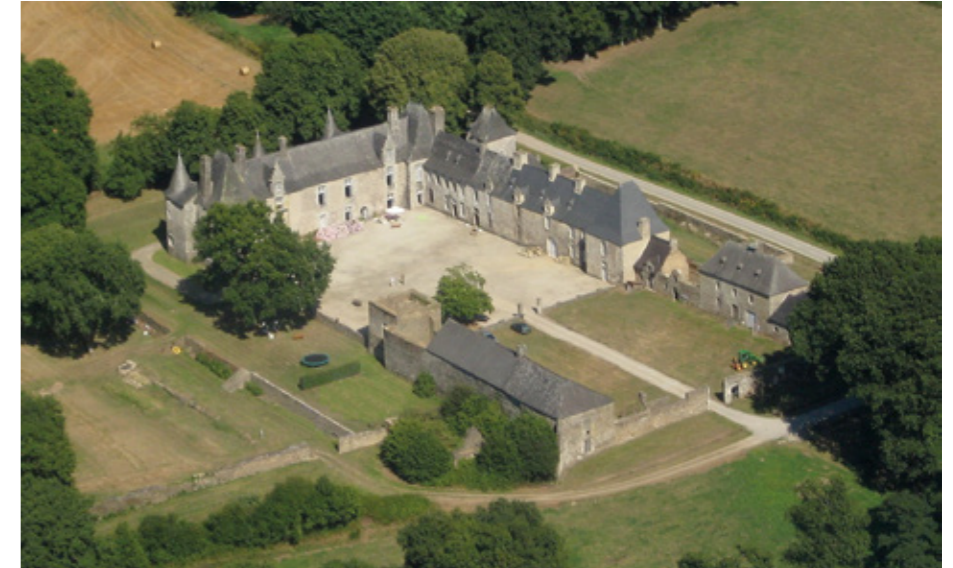
1. Vue générale du site avant la restauration de la chapelle
