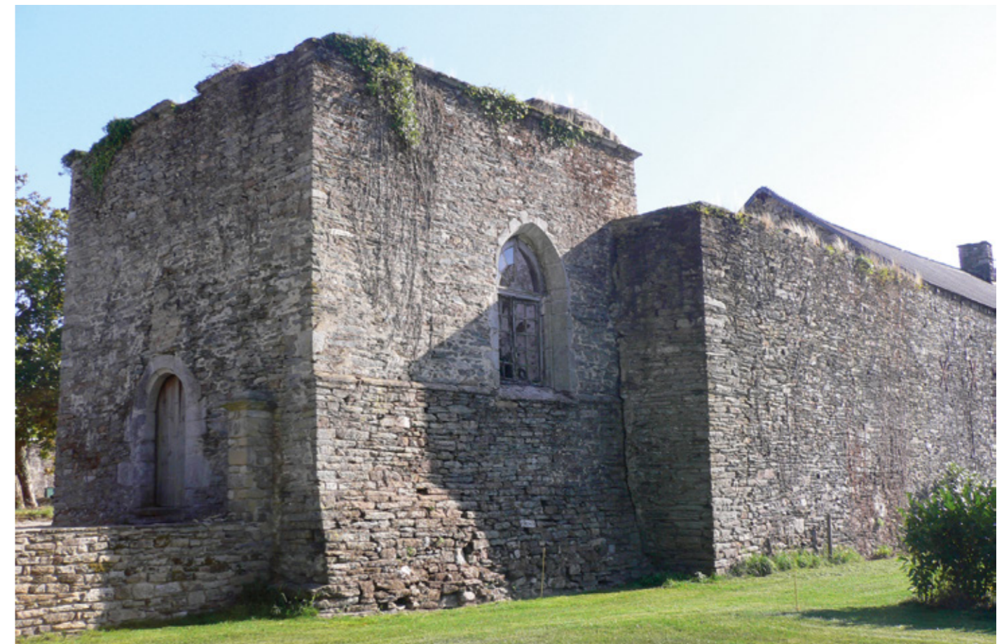
2. Vue nord-ouest de la chapelle avant restauration
