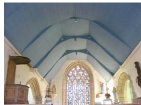
5. Vue des voûtes vers le chœur
