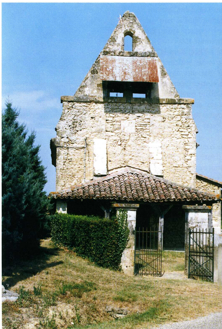
Lussan (Gers) Chapelle Notre-Dame-des-Neiges Façade occidentale
