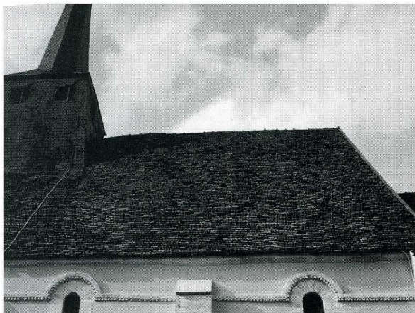
Marçais (Cher). Eglise Saint-Maurice. 1. Toiture de la nef versant sud. 2. Vue intérieure vers le chœur.
