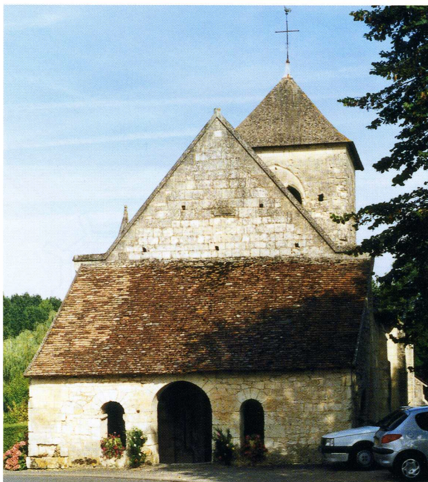
Marcé-sur-Esves (Indre-et-Loire) Église Saint-Martin 2. Porche de la façade occidentale
